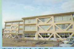
東五位小学校の耐震化 (H23.11.22)
