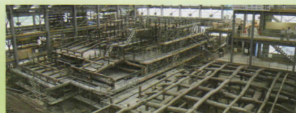
勝興寺保存修理
