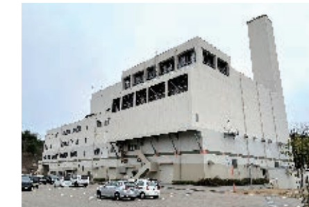
高岡広域エコ・クリーンセンター竣工(2014年10月)
