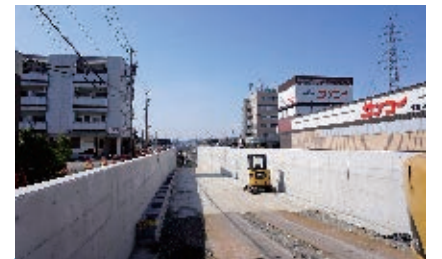
下伏間江福田線立体交差(京田踏切アンダーパス) 整備工事一部共有開始(2021年6月(予定))
