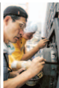
御車山車輪修復
