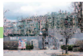
志貴野中学校 改築工事
